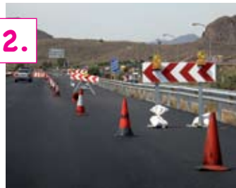
Señalización circunstancial que modifique el régimen normal de utilización de la vía y señales de balizamiento fijo
